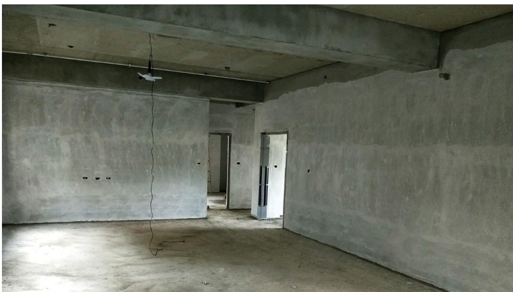
2 樓電氣管路配線
